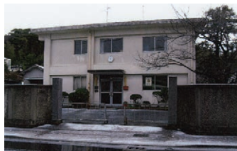
昭和41年改築 鉄筋コンクリート二階建
