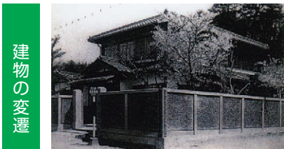
昭和8年改築 瓦葺木造二階建
