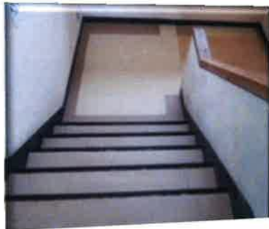
Pタイルを貼り替え 綺麗になった階段
